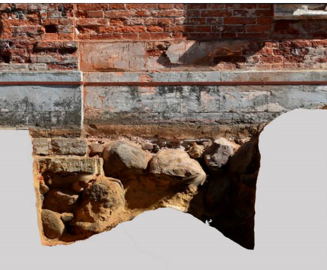
Рис. 2. Ортофотоплан (вид на стену) Шурфа №4 южного фасада.
