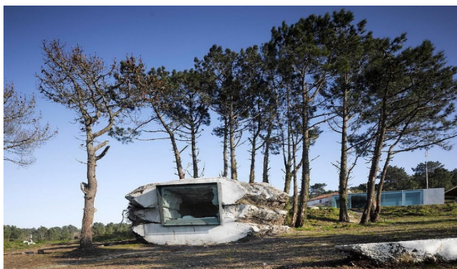
Рис. 3 Дом в камне «Трюфель» («The Truffle»), ENSAMBLE STUDIO, Испания (источник: architime.ru)
