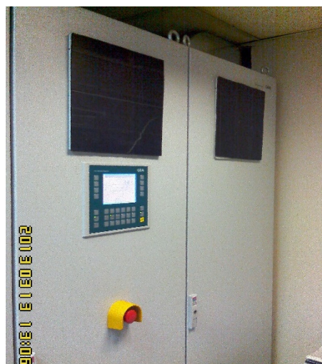
Рис.3. Штатные отверстия в шкафах закрыты
