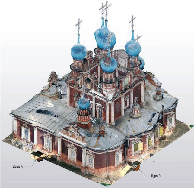
Рис. 1. Общий вид Казанской церкви (результаты лазерного сканирования) с указанием расположения шурфов: вид на северо-запад (слева), вид на юго-восток (справа).
